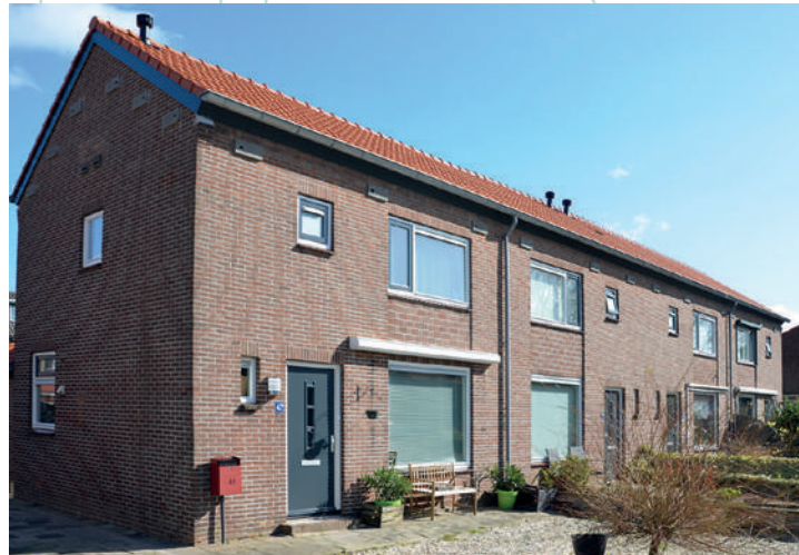
Groot onderhoud 23 woningen Maasdam
