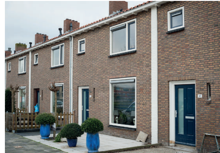
Groot onderhoud 24 woningen 's Gravenzande
