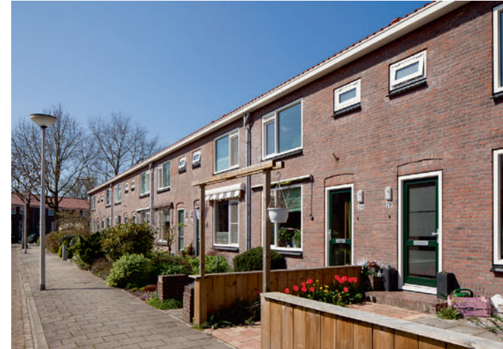
Groot onderhoud 30 woningen Nieuwerkerk
